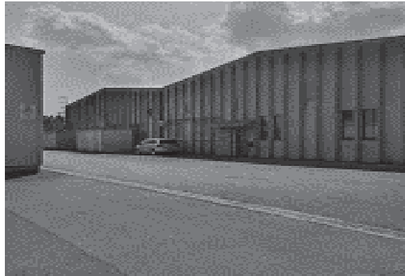
Slika 10: Zgradba podjetja Svečarstvo Jurkovič v Črnučah
